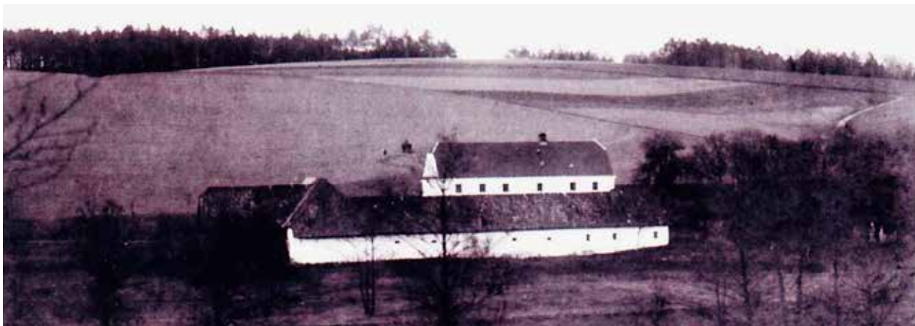
Hospodářské stavení č. p. 45 v Bystřičku
