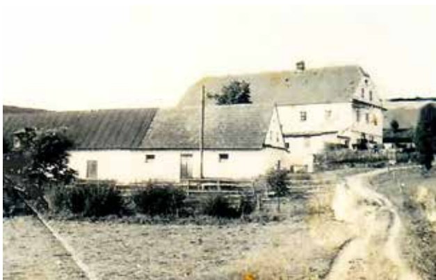
Hospodářské stavení č. p. 45 v Bystřičku
