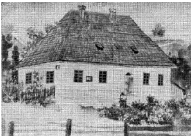
Budova č. p. 89
