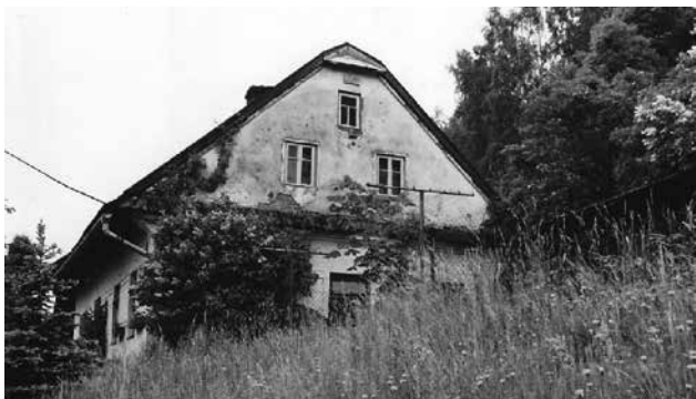
Budova č. p. 95
